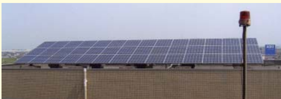
太陽光パネル
