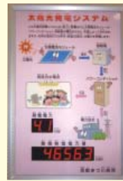
太陽光電気発電量表示板
