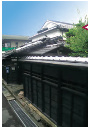
通りからの外観
