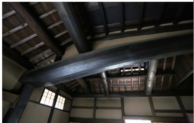
復元時、天井に沿って曲線を描く柱に天橋立の松材が使われた
