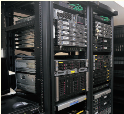
サーバーは、温度管理されたスペースに設置
